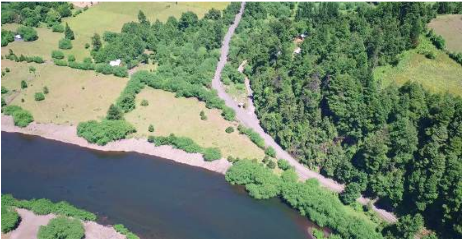
Figura 3. Protección de riberas en orillas del río Trancura. Fotografía: Laboratorio de Recursos Hídricos, UC Temuco.
