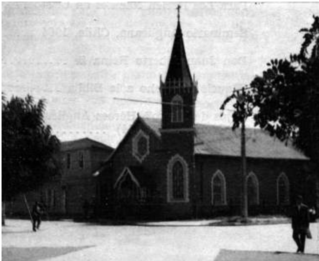
Trinity Church, Iglesia Anglicana de Temuco, típica construcción de madera de principios de siglo. Vicuña Mackenna esquina Lautaro. Fuente: www.memoriachilena.cl
